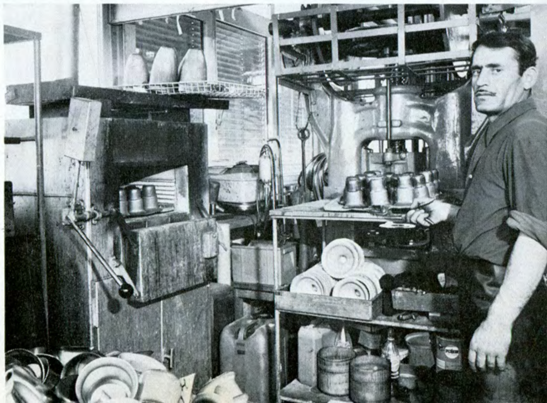
Glühabteilung mit zwei elektrischen Glühöfen bis 1000°
